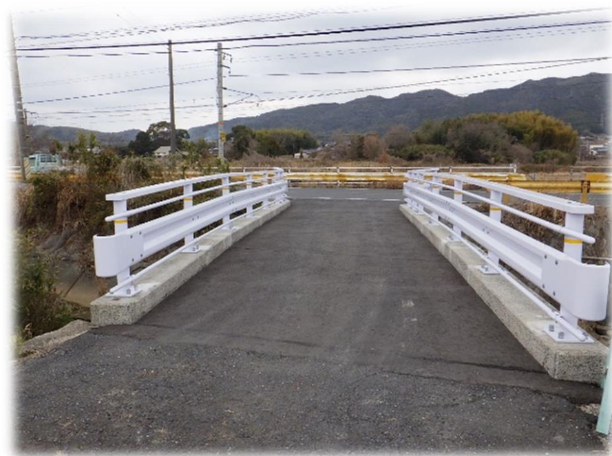
令和3年度実施 臥龍橋(余田地区)
