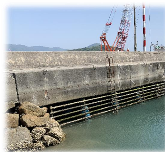
遠崎防波堤（鳴門漁港）
