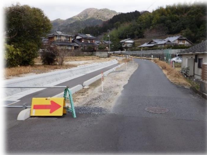
宮本水口線道路改良工事（継続事業）
