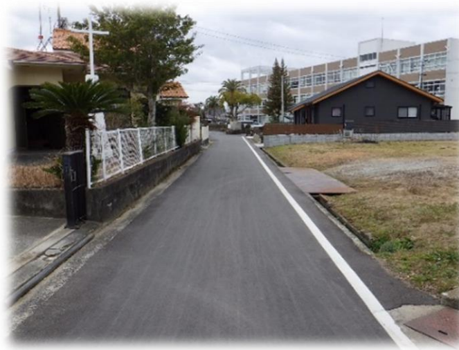
令和3年度実施 境開広瀬一里木線舗装工事
