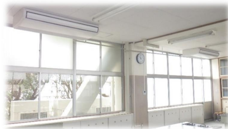
令和4年度実施 空調設備整備 (新庄小)
