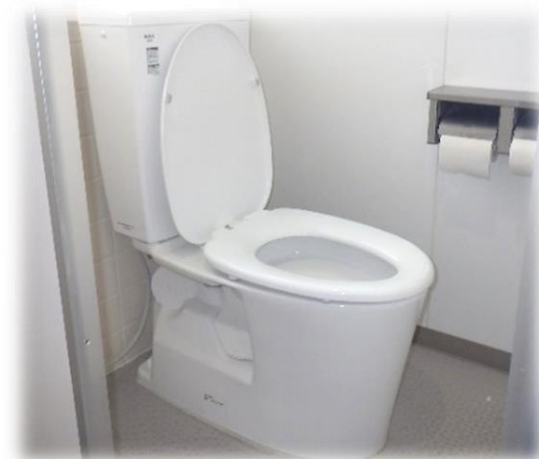
令和2年度実施 トイレ洋式化改修 (小田小)
