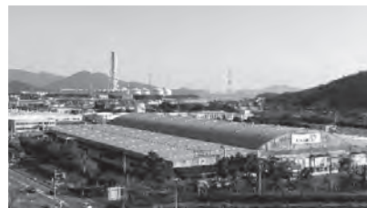
◀南浜地区遠景
