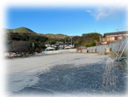
阿月小学校 解体後
