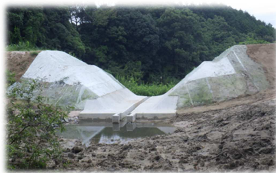
堤体切開後の状況（清徳ため池）
