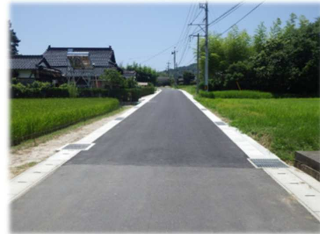
鍛冶屋原線道路改良工事
