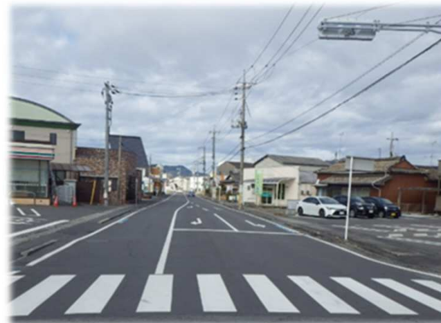
古開作中開作線舗装工事
