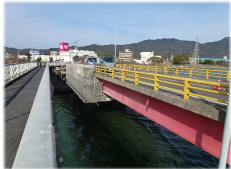
新旭橋橋梁補修工事（継続事業）
