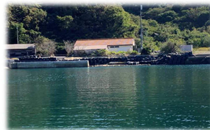
平郡漁港（蒲地区）の補修状況
