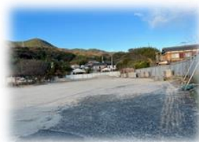
阿月小学校 解体後
