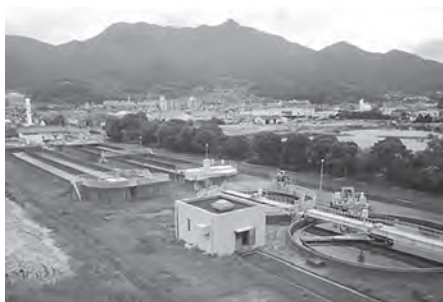
▲今年度工事予定の柳井浄化センター
