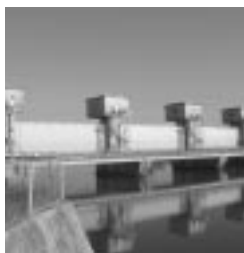
土穂石川排水機場
