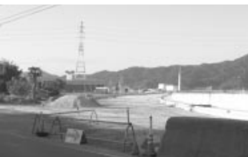
県道柳井上関線の改良工事
