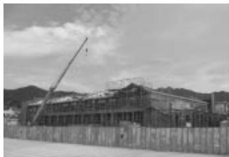
柳井小学校の建築工事
