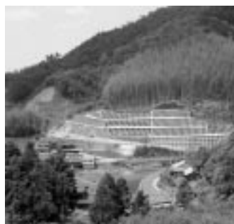
鳴門地区の農道整備
