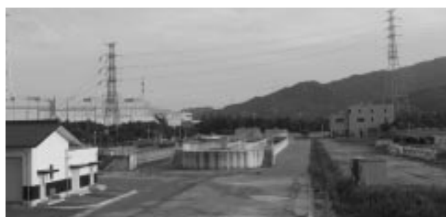
公共下水道の浄化センター（宮本塩浜）
