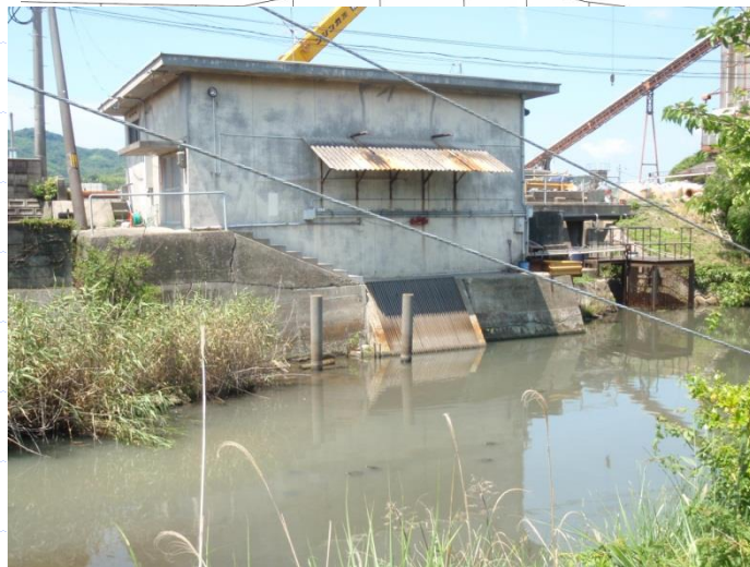
既設ポンプ場
