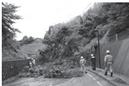
▲市斎苑入口の崩落(平成21年7月)
