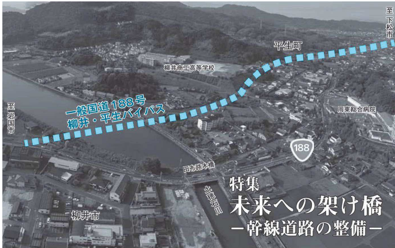
▲上空から見た柳井・平生バイパスの予定ルート
