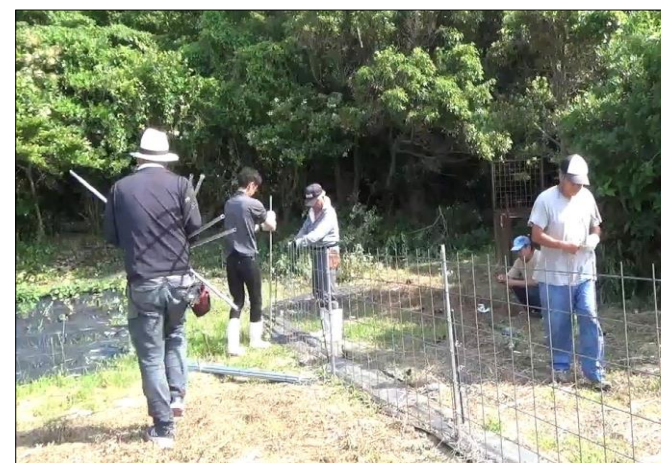
ワイヤーメッシュの設置作業
