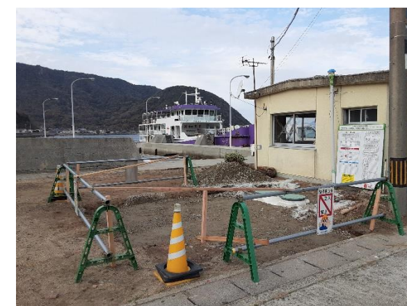
12/21 撮影 工事のため立入禁止
