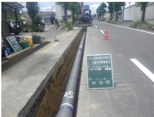
写真② 新市地区配水管布設替状況
