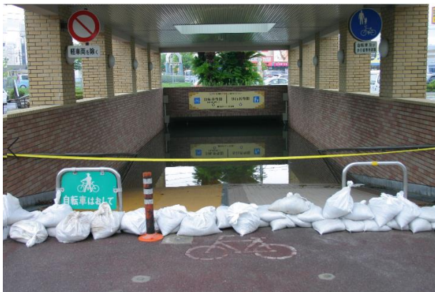
H17.7 豪雨 柳井駅南北地下道
