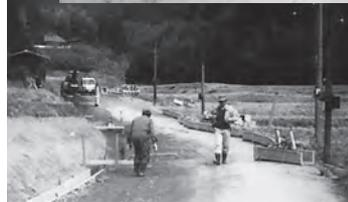
▲重機による掘削や道路側溝くっさくの設置を行います。
