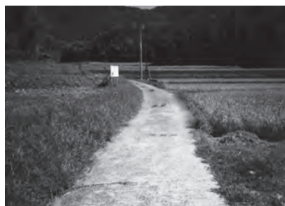
▲もともと道幅が2mほどの道路でした。
