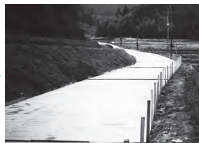
▲最後に舗装を行い完成です。
