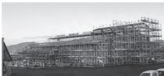
▲建設中の複合図書館
