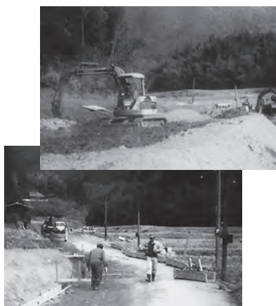
▲重機による掘削や道路側溝の設置を行います。
