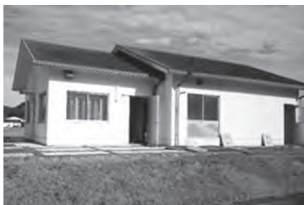
◀余田中央浄化センター (平成 5 年度供用開始)
