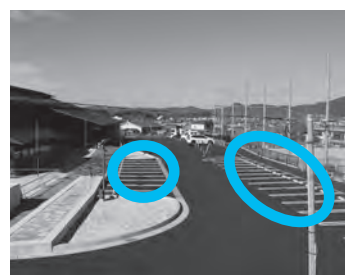
▲マンホールの位置
