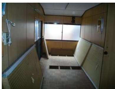
1 階キッチンスペース
