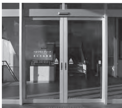
▲正面玄関など3カ所の出入口を自動ドアに変更しました。
