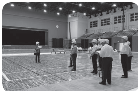
改修工事中のバタフライアリーナ
