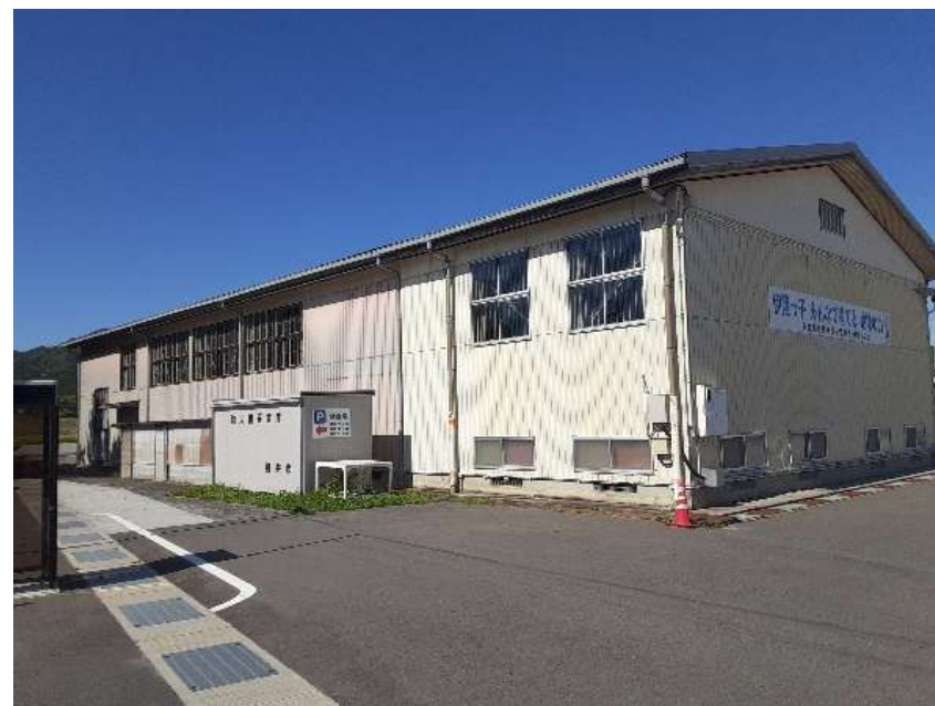
伊陸小学校屋内運動場
