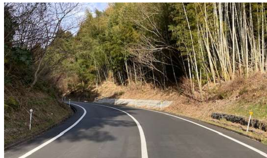
令和6年度実施 農道柳井田布施線
