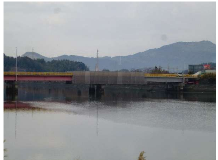
新旭橋橋梁補修工事（継続事業）
