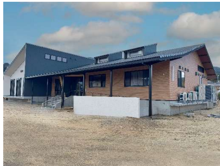
新阿月公民館建設中
