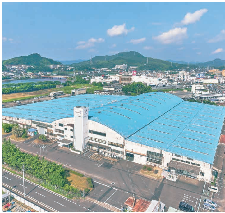
先進技術事業化センター
