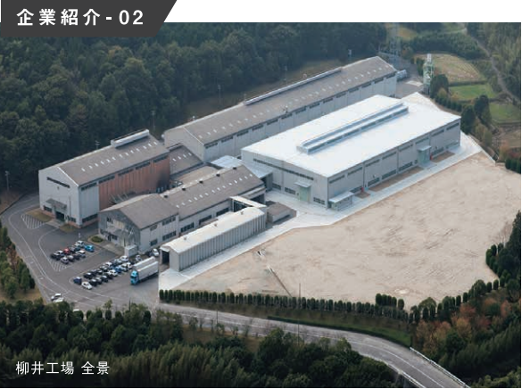
柳井工場 全景
