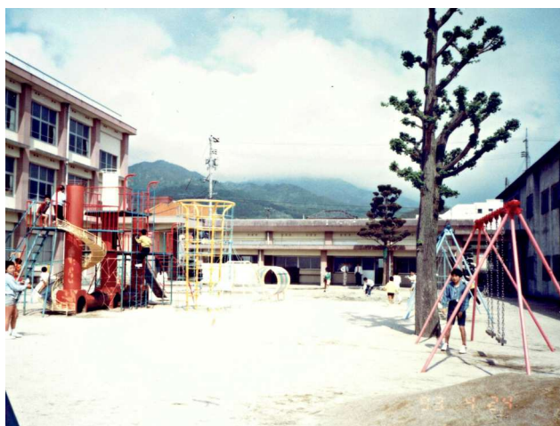
教室棟に挟まれた中央の棟の右半分が 旧理科研修所（1993年4月に撮影）
