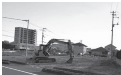
▲解体前の空き家（上）と更地になった土地（下）
