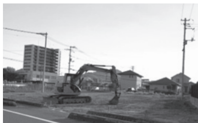
▲解体前の空き家（上）と更地になった土地（下）
