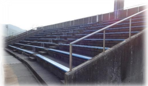
スタンド部防水改修予定箇所
