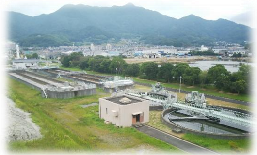
柳井浄化センター
