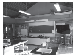
特別教室空調設備整備▶
