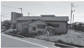
▲解体前の空き家 （イメージ）
