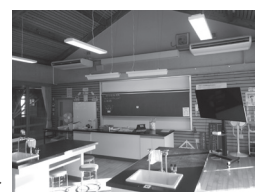
特別教室空調設備整備▶
