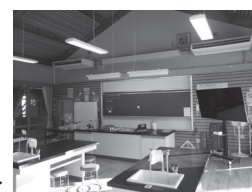
特別教室空調設備整備▶
