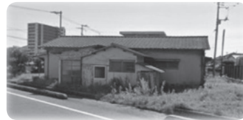
解体前の空き家
